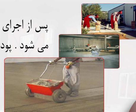
سپس با ماله های پروانه ای تک ملخه یا دو ملخه به مدت ۷ تا ۱۰ ساعت بسته به شرایط آب و هوایی عملیات پرداخت صورت می گیرد ، که این پروسه باعث اختلاط کامل پودر بوتك با بتن تازه می گردد .
